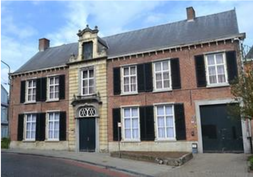
Foto van de vroegere griffierswoning van de familie Dullaert, als uniek voorbeeld van de 18 de eeuwse bouwstijl in het dorpscentrum (ArcheoNet Vlaanderen, T. Vereenoghe).
